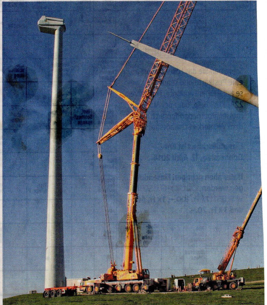
Montage eines Rotors im Entlebuch.
